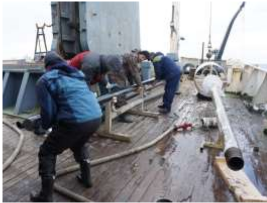
Отбор проб грунтовой трубкой. Глинистый ил послеледникового периода Балтийского моря, возраст до 10–12 тыс. лет.
