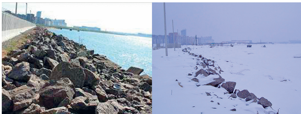
Рис. 2. Валунно-глыбовая отсыпка (лето) и общий вид южной границы участка территории Лахта-Центра (зима)
